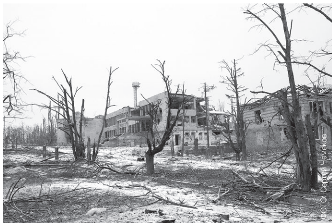
Разрушенные здания на южных подступах к Бахмуту
