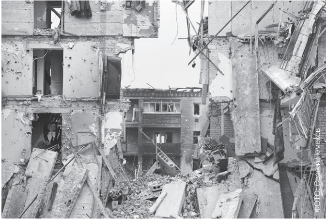
Разрушенный жилой дом в Артемовске
