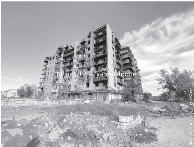
Разрушенная девятиэтажка в Попасной
