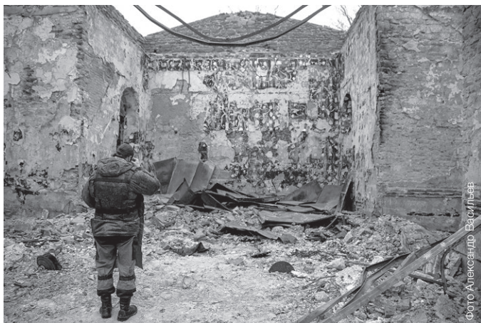
Внутри разрушенного храма Николая Чудотворца в Попасной
