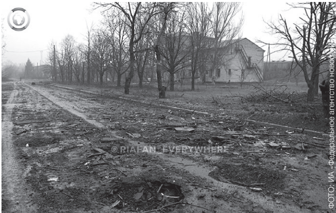
Поврежденные дороги в Попасной
