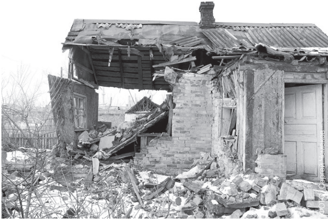
Разрушенный дом в Парасковиевке
